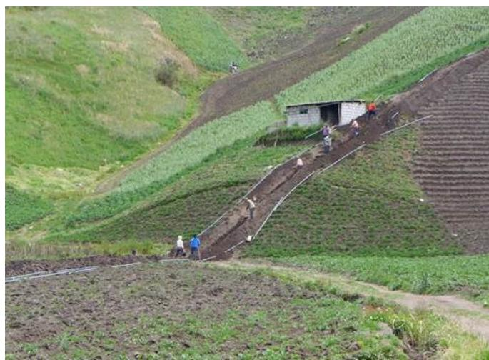
Sie sind intensiv am Arbeiten, jede Familie hat in diesem Bereich ca. 12 m des einen Meter tiefen Grabens auszuheben, damit die Leitungen verlegt werden können. Die Menschen sind sehr dankbar, dass sie dank Unterstützung aus der Schweiz nun eine funktionierende Versorgung mit sauberem Trinkwasser bekommen werden, die zusammen mit ergänzenden Dusch- und Toiletteneinrichtungen die Voraussetzungen für eine gesunde Lebensbasis erheblich verbessern.
